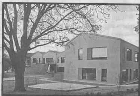
Naturverbundenheit, die am Gebäude ablesbar ist. Von Mia2 Architektur.
